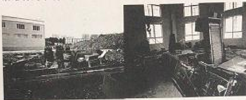
图三、华耀城附近泵站现状
