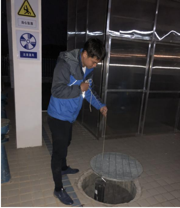
废水进口采样点
