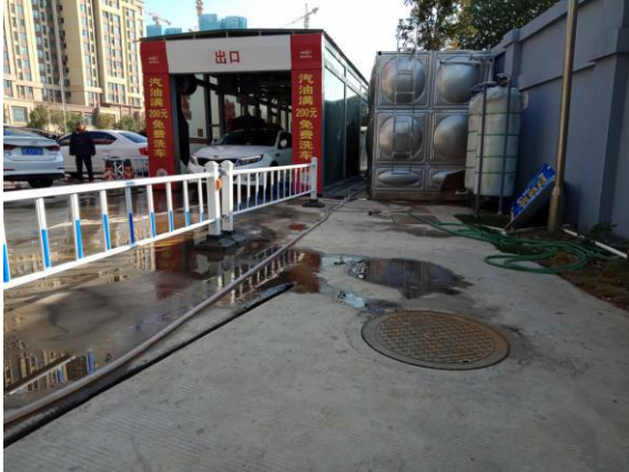
三级隔油沉淀池
