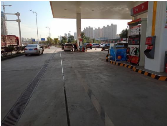
油气回收装置
