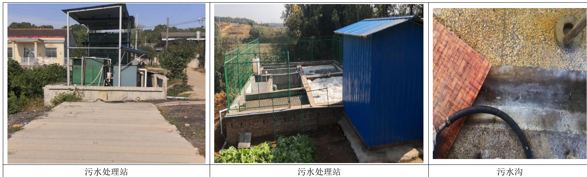
图 4.1-1 项目废水处理设施照片
