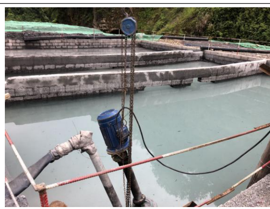
场内雨水沉淀池
