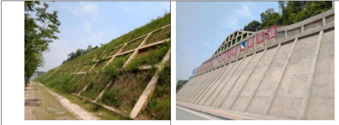
公路两侧边坡防护
