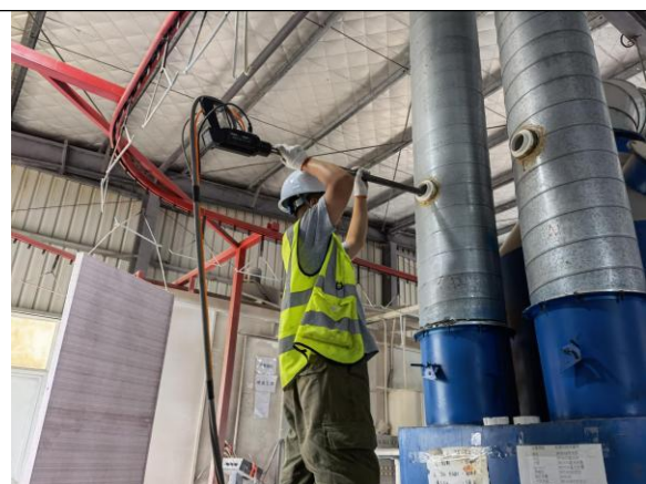
喷粉废气处理设施进口 2
