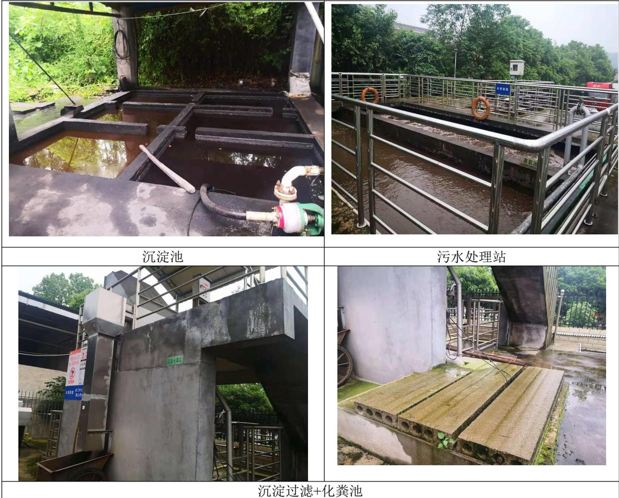
图 4.1-1 项目废水处理设施照片
