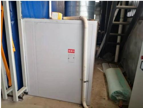
喷漆废气：过滤棉
