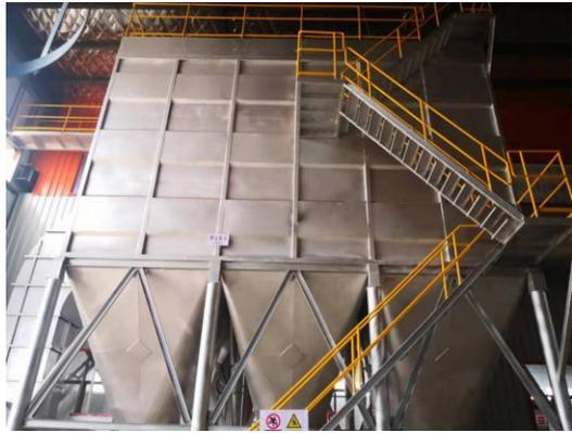
打磨废气、焊接烟尘、以及氧割：布袋除尘
