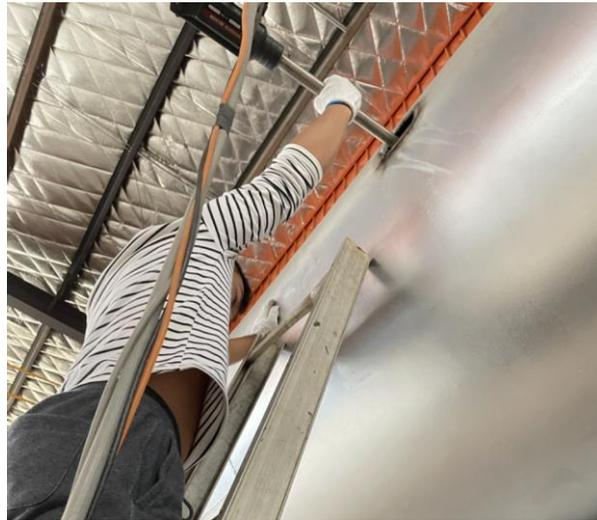
打磨、焊接、氧割排气筒 (DA004) : 进口
