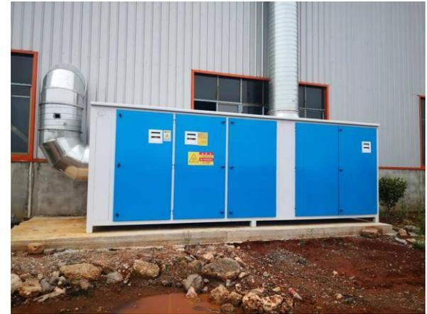
喷漆废气：活性炭吸附+UV 光解→高排气筒
