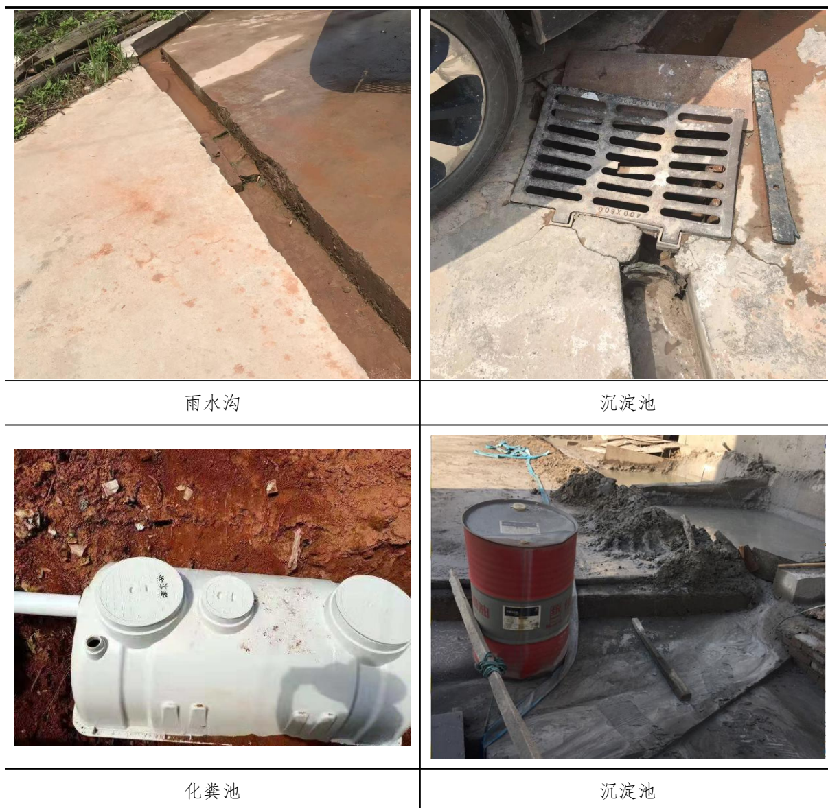
图 4-1 废水处理设施照片
