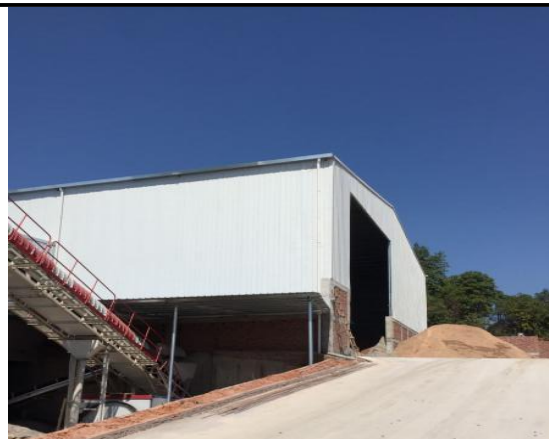
半封闭式砂石堆场
