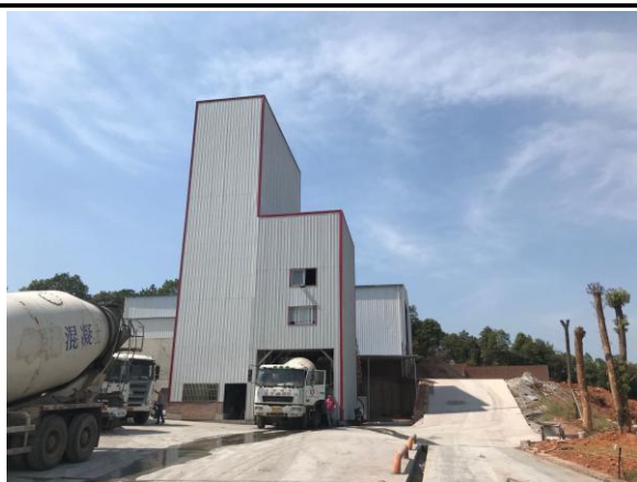
封闭式湿拌砂浆厂房
