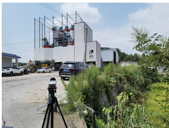
封闭式干混砂浆厂房
