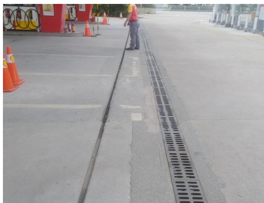
雨水沟、截流沟
