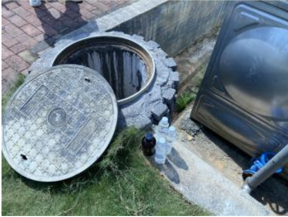
废水出口采样照片
